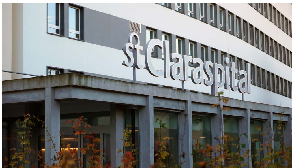
L'entrée principale du Claraspital à Bâle, dans la Kleinriedenstrasse.
