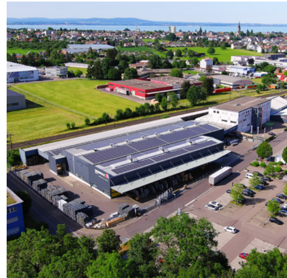
↑ Am Firmenhauptsitz in Romanshorn (TG) produziert Gebrugg Lösungen, ...
